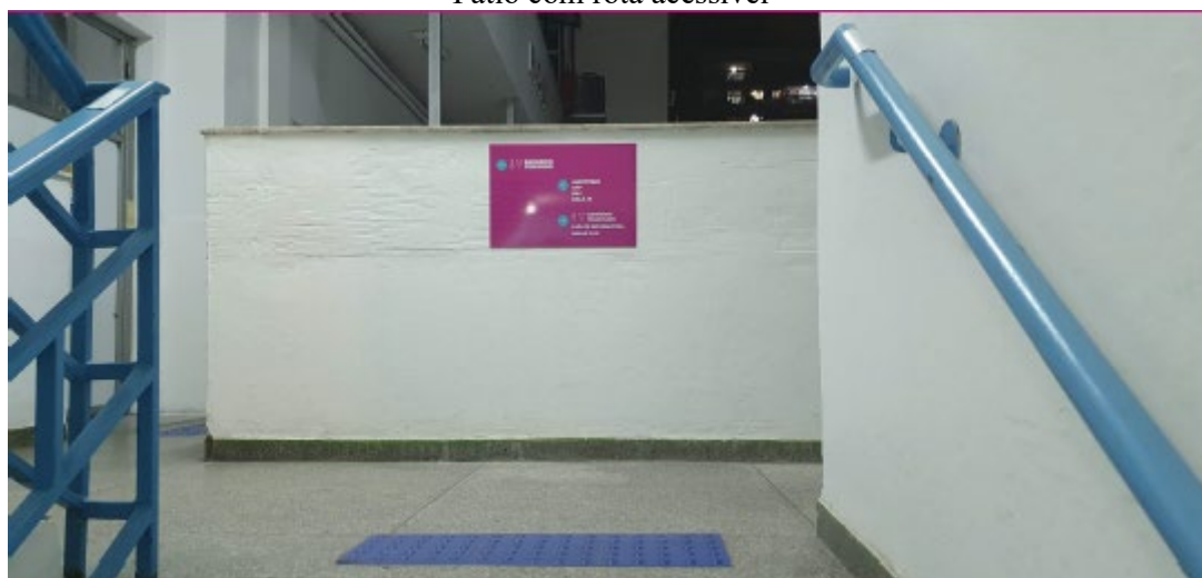
Escadas com corrimão com sinalização em braille e piso tátil
